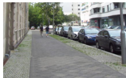
diagonalverlegte Kunststeinplatten, Mosaik im Unter- und Oberstreifen, Markgrafenstraße
