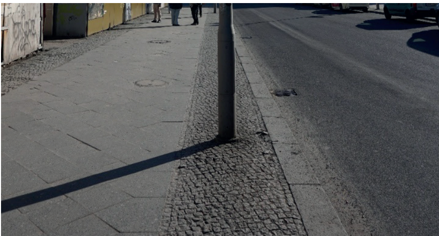
Abb. 61: Friedrichstraße Bodenbeläge Gehweg und Straße (Quelle: ISR, 2026)
