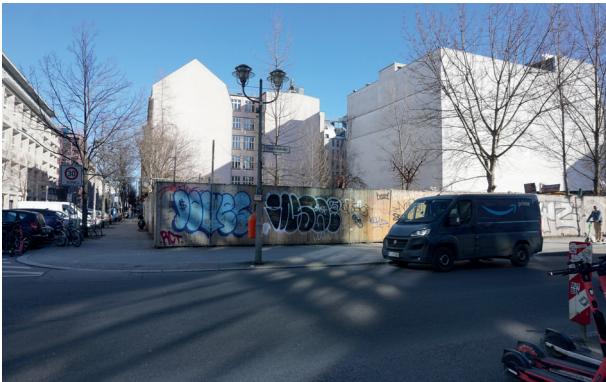
Foto 22: Kreuzung Friedrichstraße/Schützenstraße, Blickrichtung Osten auf Brandwand Zimmerstraße 79-80
