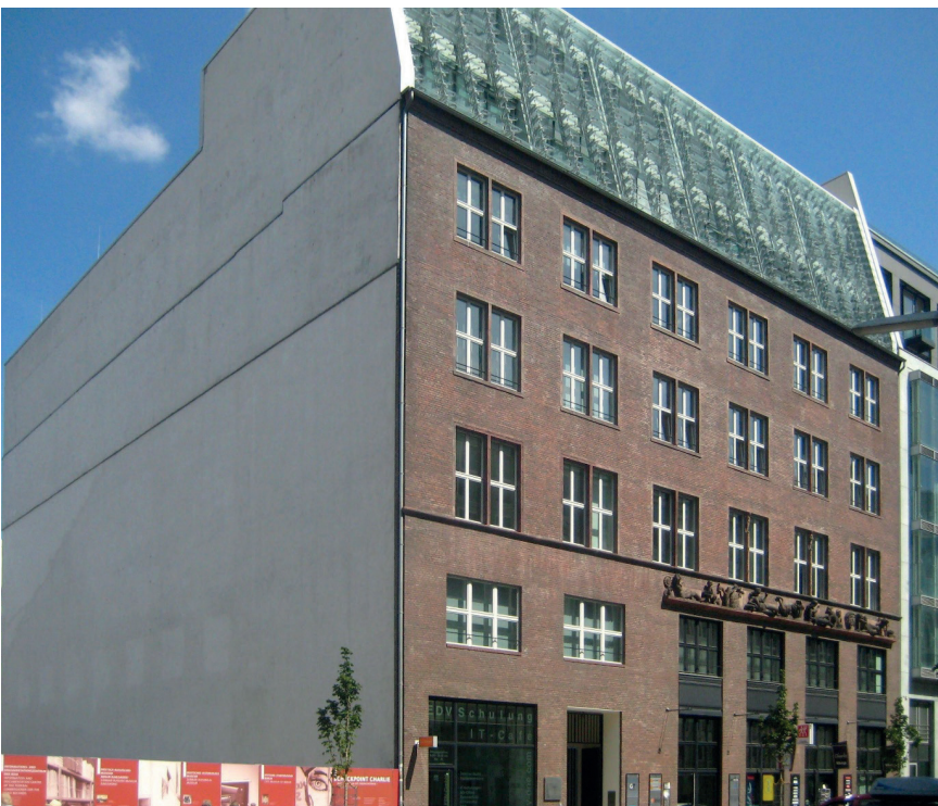
Abb. 11: Bestandsgebäude Zimmerstraße 79-80 (Quelle: Wikimedia Commons)
