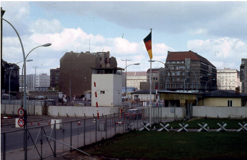
Abb. 20: Die heutige Gemeinbedarfsfläche Ende der 1970er Jahre: Panzermauer mit einbetonierten Schienen mit Wellplatten verkleidet, Panzersperren abgetragen, Fundamentierung aber noch z.T. im Bewuchs erkennbar. (Quelle: Hans-Joachim Grimm/ Stiftung Berliner Mauer)
