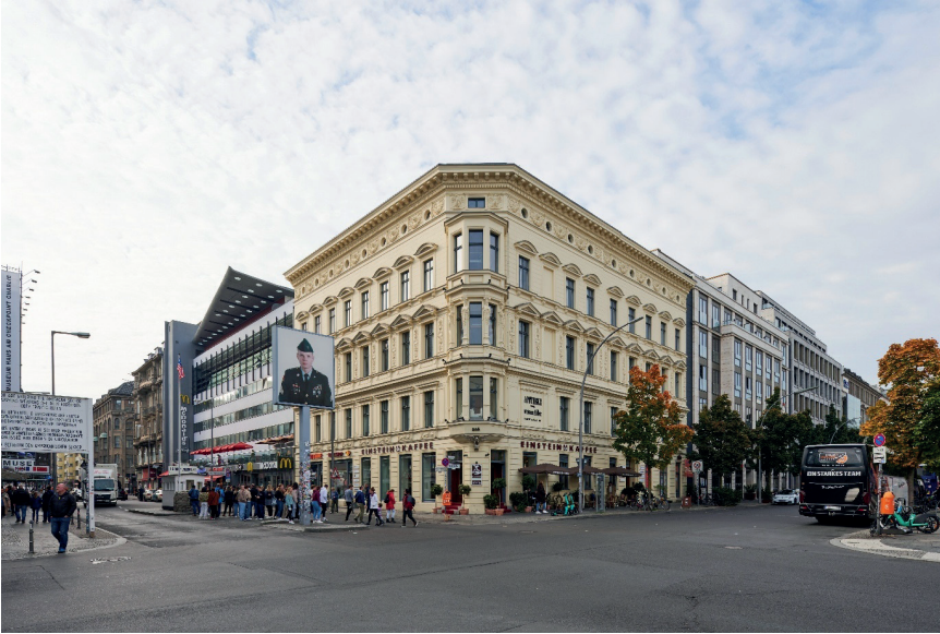
Abb. 13: Bestandsgebäude Friedrichstraße 206 (Quelle: Andrew Alberts, 2023)
