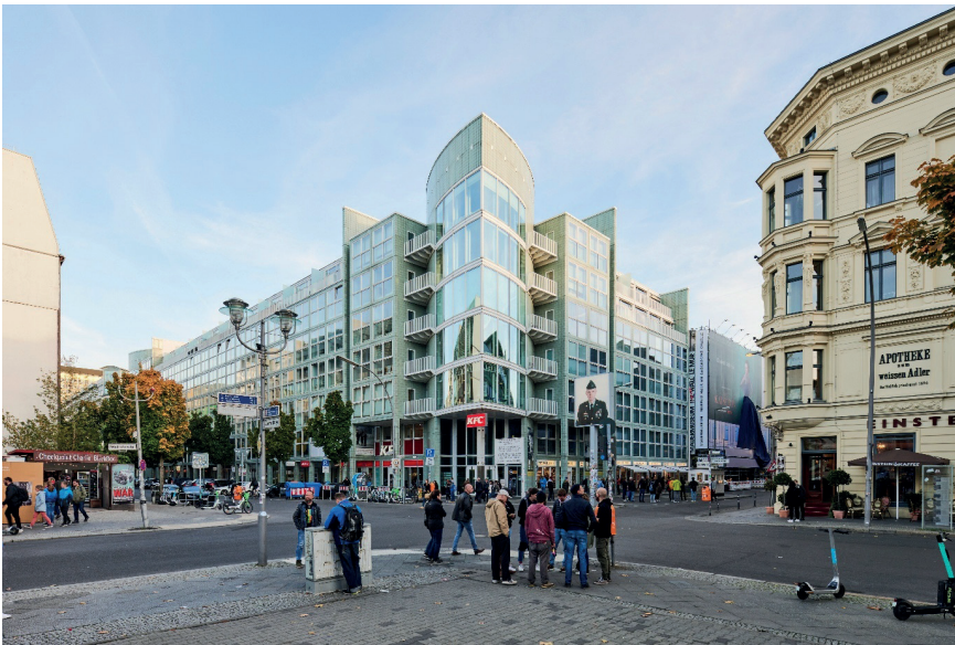
Abb. 12: Bestandsgebäude Friedrichstraße 45 (Quelle: Andrew Alberts, 2023)
