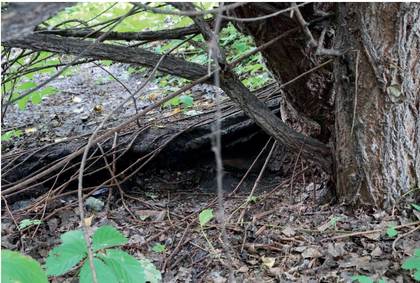
Abb. 25: Asphaltierung der Grenzübergangsstelle, durch Baumwuchs angehoben auf der Gemeinbedarfsfläche (Quelle: Stiftung Berliner Mauer, 2025)
