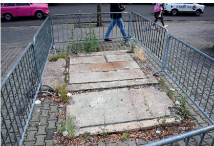
Abb. 26: Fundamentrest am südlichen Rand des Stadtplatzes. Wahrscheinlich teilweise abgetragener Kabelschacht innerhalb des Hochbeetes im ehemaligen Grenzstreifenabschnitt (Quelle: Stiftung Berliner Mauer, 2025)
