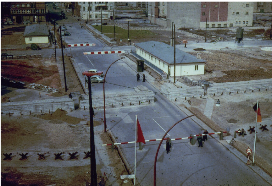
Abb. 19: Detailansicht der Panzersperren und der Panzermauer 1962 (Quelle: Privat/Stiftung Berliner Mauer)
