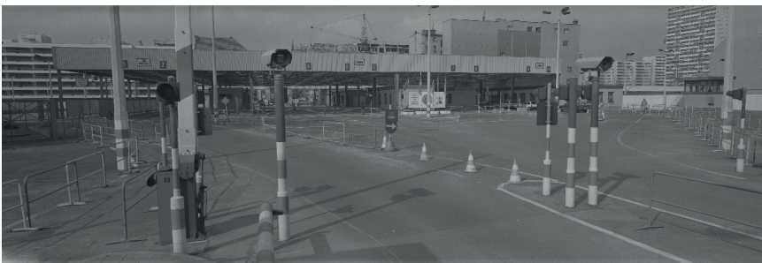
Abb. 17: Panorama der Grenzübergangsstelle Friedrich-/Zimmerstr. ab Mitte der 1980er Jahre. Aufnahmeort etwa auf dem heutigen Stadtplatz, Blickrichtung nach Nordosten (Quelle: Bundesarchiv, Stasi-Unterlagen-Archiv)
