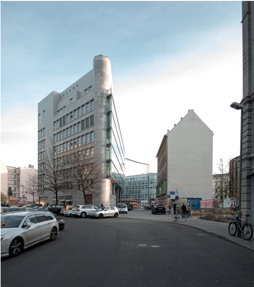
Abb. 9: Bestandsgebäude „Haus Triangel“ (Quelle: SenStadt)
