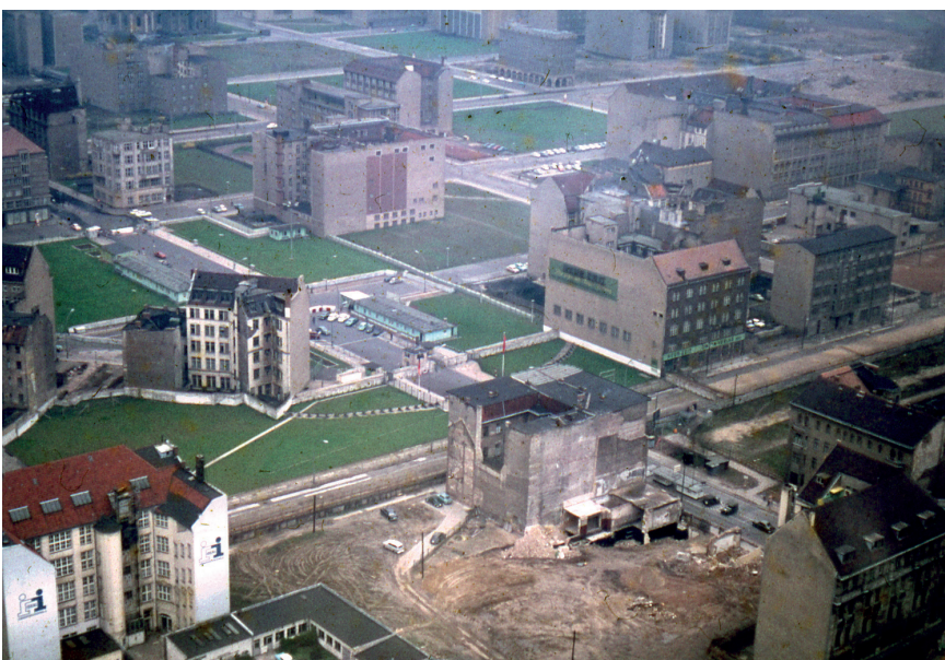
Abb. 16: Luftaufnahme des Grenzstreifens und des Grenzübergangs Friedrich-/Zimmerstraße in den 1960er Jahren (Quelle: Hans-Joachim Grimm/Stiftung Berliner Mauer)
