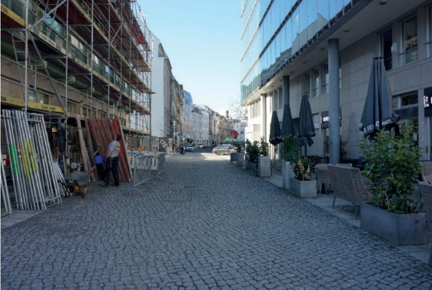
Abb. 62: Mauerstraße Bodenbelag (Quelle: ISR, 2026)
