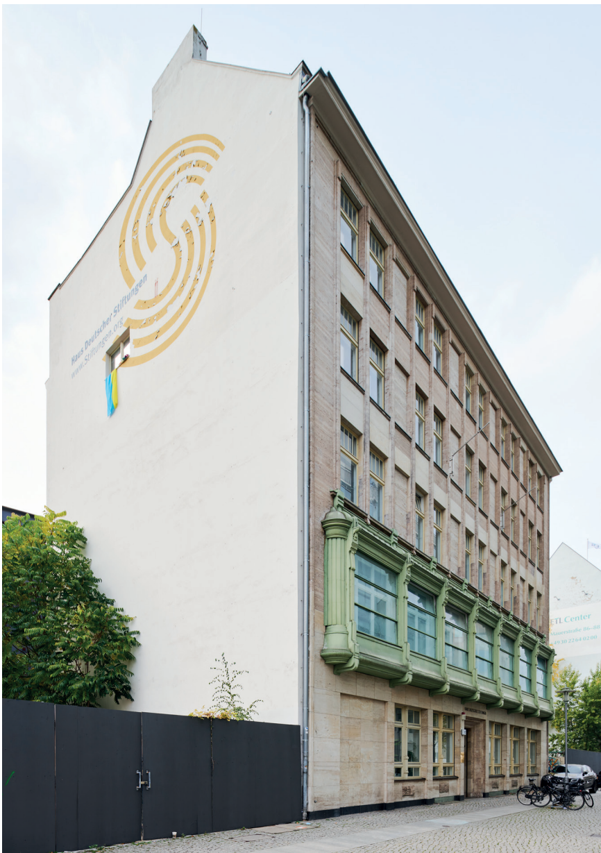
Abb. 8: Bestandsgebäude Mauerstraße 93 mit Observationsfenster (Quelle: Andrew Alberts, 2023)
