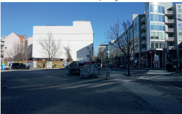
Foto 28: Stadtplatzfläche, Blickrichtung Osten auf die Kreuzung Friedrichstraße/Zimmerstraße und Brandwand Zimmerstraße 79-80
