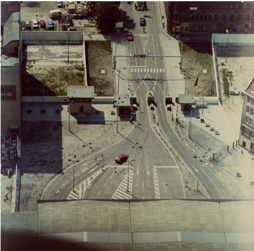
Abb. 23: Luftaufnahme des Zufahrtsbereichs der Grenzübergangsstelle Friedrich-/Zimmerstr. ab Mitte der 1980er Jahre mit den beiden Postenhäusern und dem Führungspunkt. (Quelle: Bundesarchiv, Stasi-Unterlagen-Archiv)
