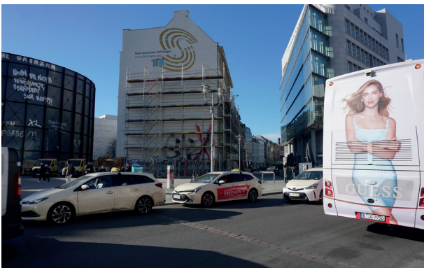
Foto 3: Gebäude Mauerstraße 93 und Haus „Triangel“, Blickrichtung Mauerstraße
