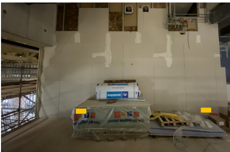
Abbildung: IMG_1636.HEIC_IMG_1640.HEIC.png ; hier mit schematischen Markierungen der Position der Doppelsteckdosen (Fotos: kk-archpro).
