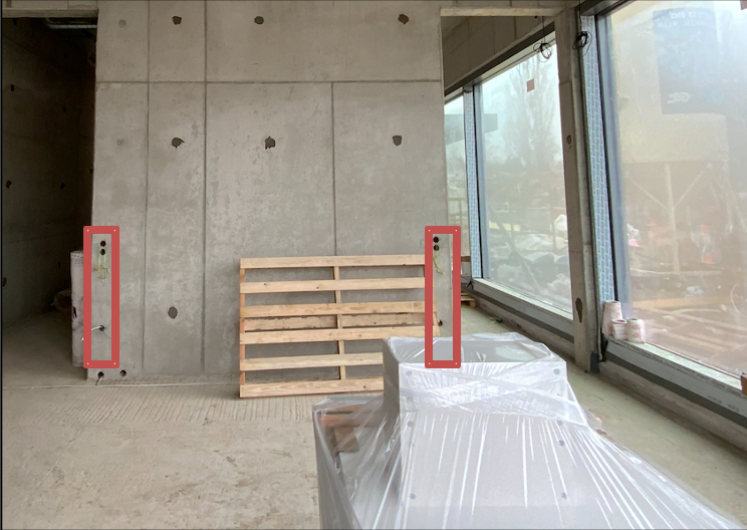
Abbildung: Ausschnitt aus IMG_1595.HEIC.png - die Auslassungen für Steckdosen und Lichtschalter sind schematisch farbig markiert. Foto: kk-archpro
