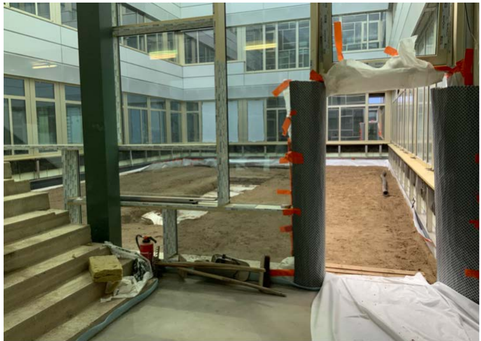
Foto rechts: Baustelle - Blick in den Innenhof 4 - die Rigole ist fertig gebaut (weiße Fläche im Zentrum) © kk-archpro
