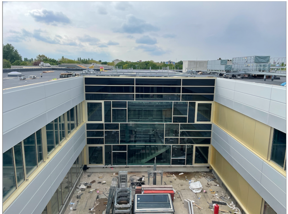
Foto rechts: Baustelle - Blick in den Lichthof 2 © NAK Architekten
