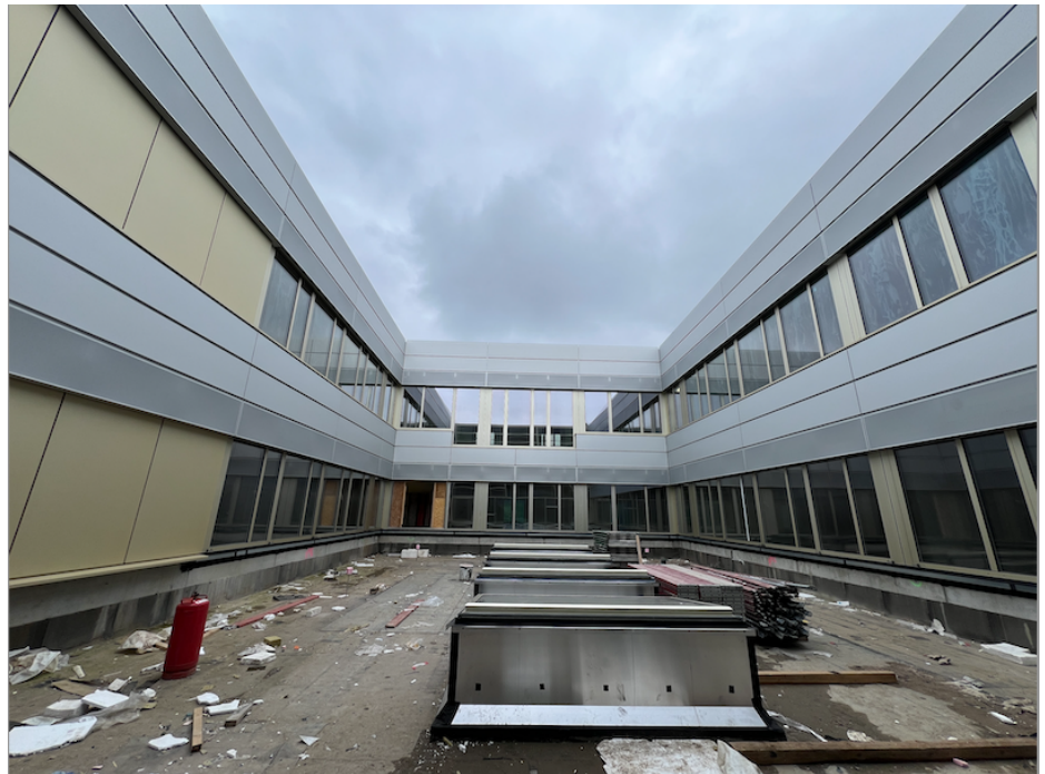
Foto rechts: Baustelle - Blick in den Lichthof 2 © kk-archpro
