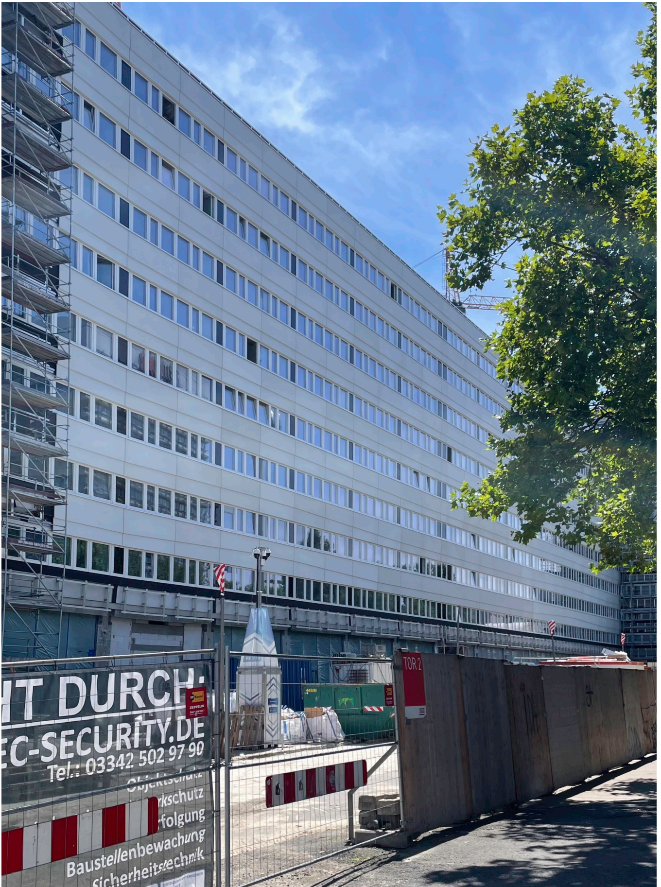
Abb. 41: Neue Fassade am Haus der Statistik im Juli 2024
