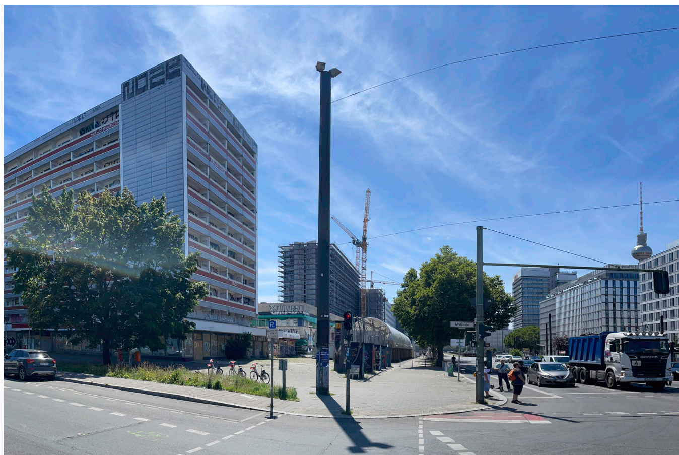
Abb. 39: Blick nach Süden, links im Bild das ehemalige Hotel, Mollstr. 4, mittig Gehweg und Platanenreihe vor dem Baufeld - im Vordergrund das „Otto“ - Juli 2024
