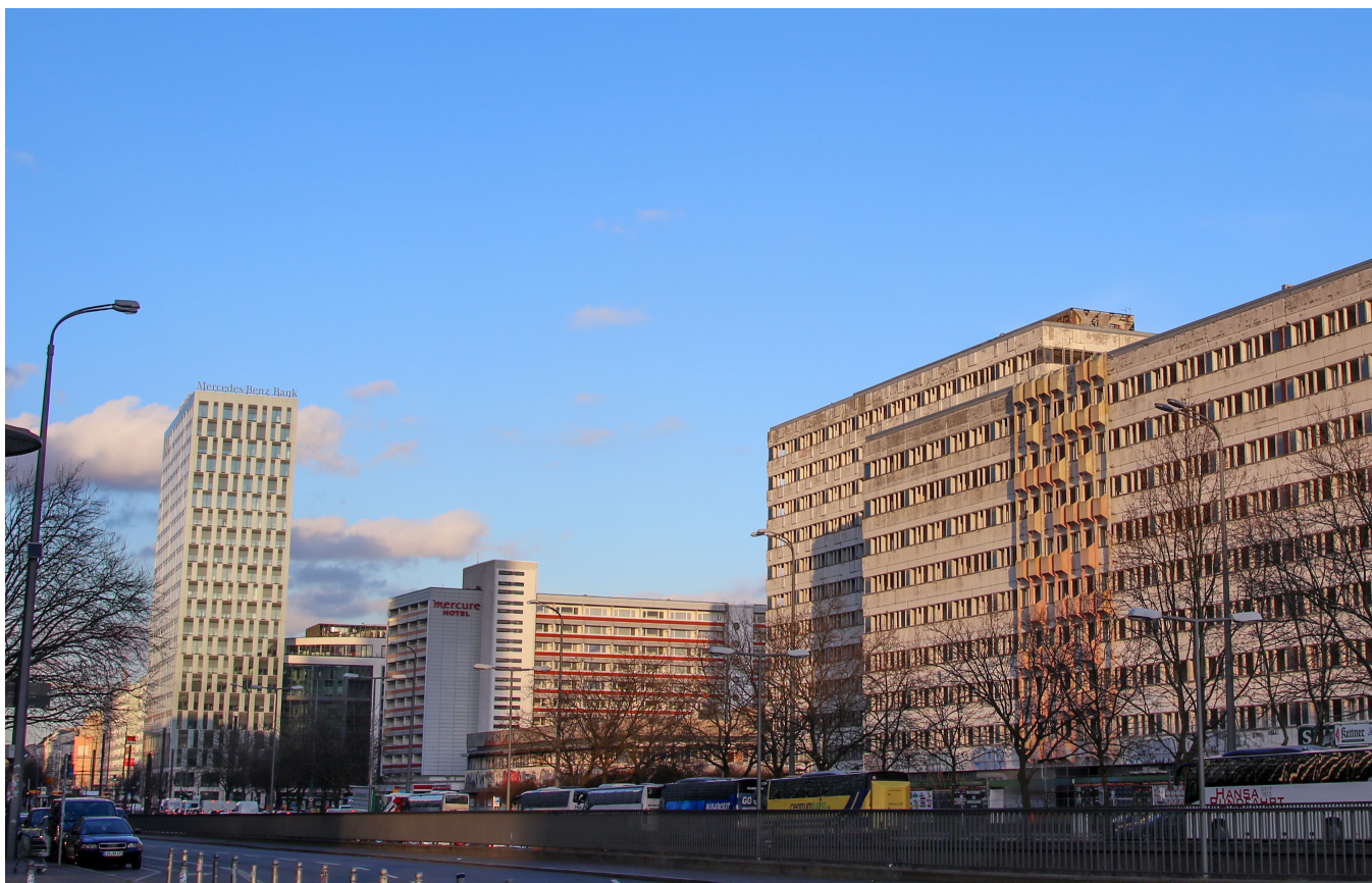
Abb. 36: Blickrichtung wie oben: im Vordergrund das Baufeld, im Hintergrund das ehemalige Hotel (Mollstr. 4) und Mercedes Benz Bank - Februar 2018
