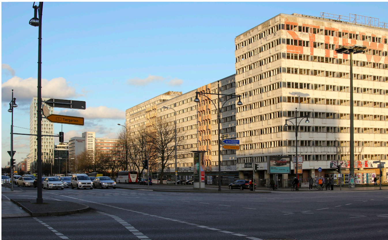
Abb. 35: Blick in Richtung Norden auf das Haus der Statistik, Gebäudeteile A bis D, Kreuzung Alexanderstraße/Otto-Braun-Straße - Februar 2018
