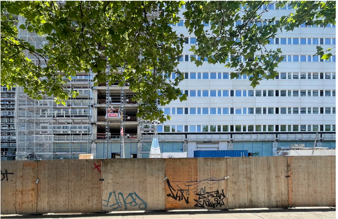
Abb. 42: Neue Fassade am Haus der Statistik im Juli 2024
