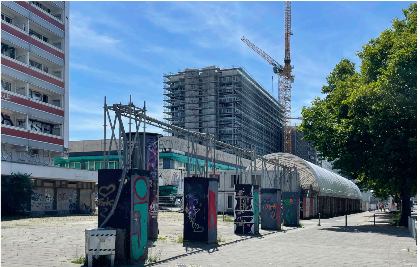
Abb. 38: Blick nach Süden, links das ehemalige Rechenzentrum, das Haus der Statistik eingerüstet während der Sanierung - Juli 2024
