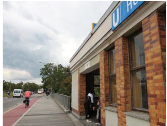
Foto 42: Eingang U-Bahnhof Hellersdorf, Blickrichtung Süden
