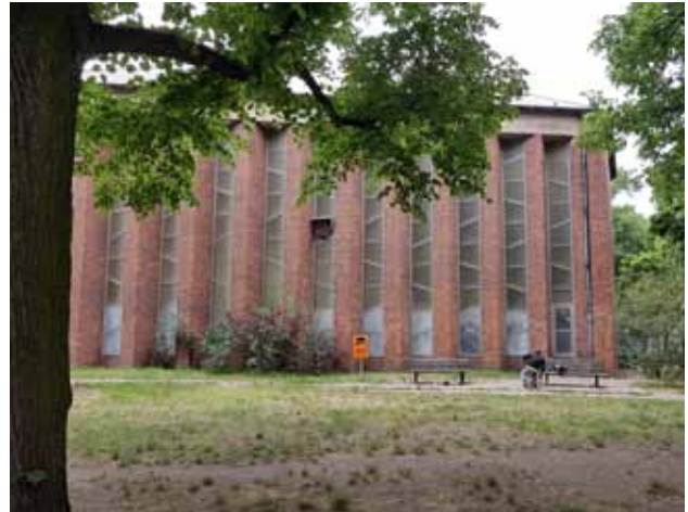
Foto 20 : übernutzte Rasenfläche vor dem Schiff der Emmauskirche
