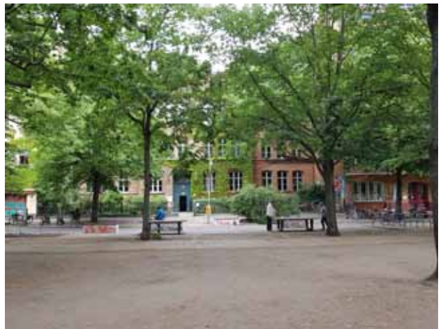
Foto 16 : Blick auf den denkmalgeschützten Schulbau von der Platzmitte, im Vordergrund Tischtennisplatten in ehemaligen Parkbuchten
