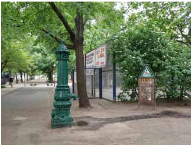
Foto 27 : Notwasserbrunnen mit Ablaufmulde
