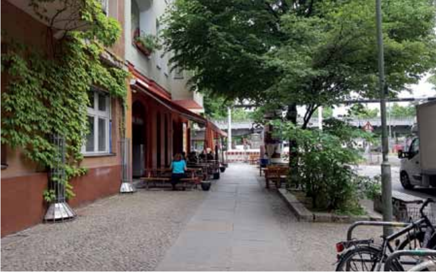
Abb.30 Gehweggliederung in Oberstreifen, Gehbahn und Unterstreifen; Quelle: Schwarz
