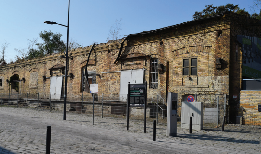
Abb. 13: Ladestraße West, Ruine am nördlichen Ende, Foto Hillig Architekten, 2020
