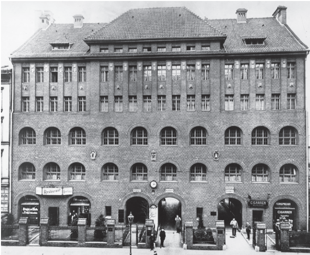
Abb. 15: Altbau um 1910, heute Haupteingang an der Trebbiner Straße
