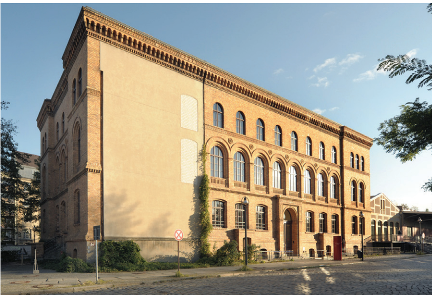
Abb. 12: Erhaltener östlicher Flügel des Kopfbaus, Landesdenkmalamt, 2011
