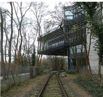
Abb. 27: Gleise, Blick nach Süden
