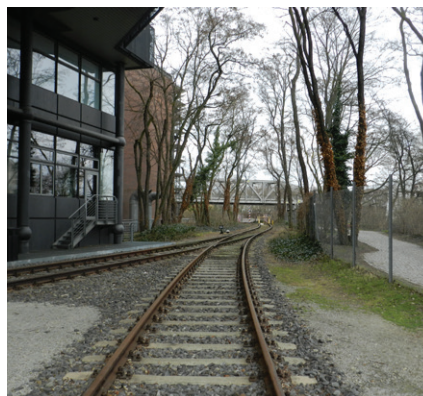
Abb. 28: Gleise, Blick nach Norden
