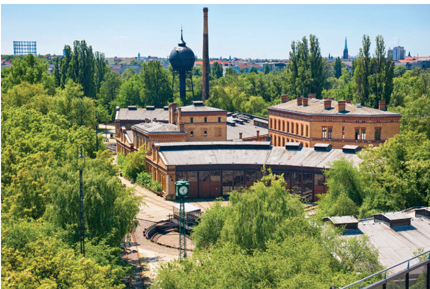
Abb. 18: Bahnbetriebswerk mit Lokschuppen und Drehscheibe, 2020, Foto Clemens Kirchner
