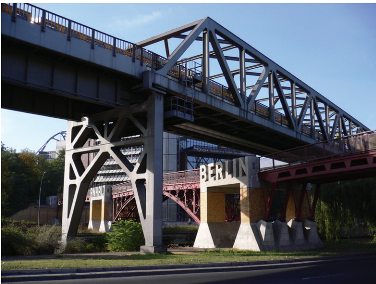
Abb. 07: Anhalter Steg mit U-Bahn-Viadukt über den Landwehrkanal, im Hintergrund das DTMB, @ Georg Slickers
