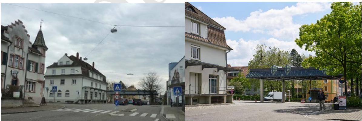
Abb.11,12: Fotos Zolldach und ‚Altes Zollhaus‘
