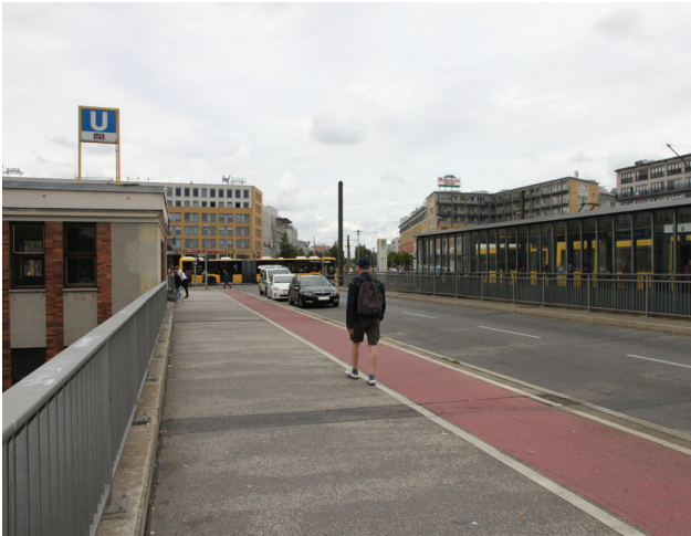
Foto 41: Stendaler Brücke mit U-Bahnhof und Straßenbahnhaltestelle, Blickrichtung Norden
