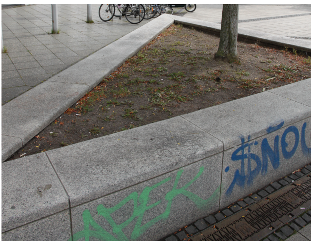
Foto 51: Detail Betoneinfassung mit Baumpflanzung
