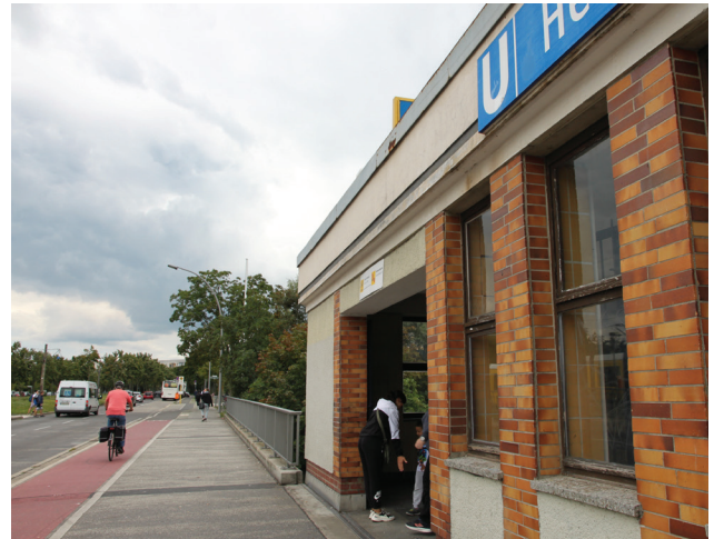
Foto 42: Eingang U-Bahnhof Hellersdorf, Blickrichtung Süden
