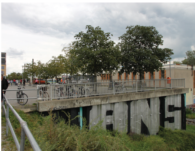
Foto 49: Südlicher Platz mit der Stützwand in Richtung Bahntrasse
