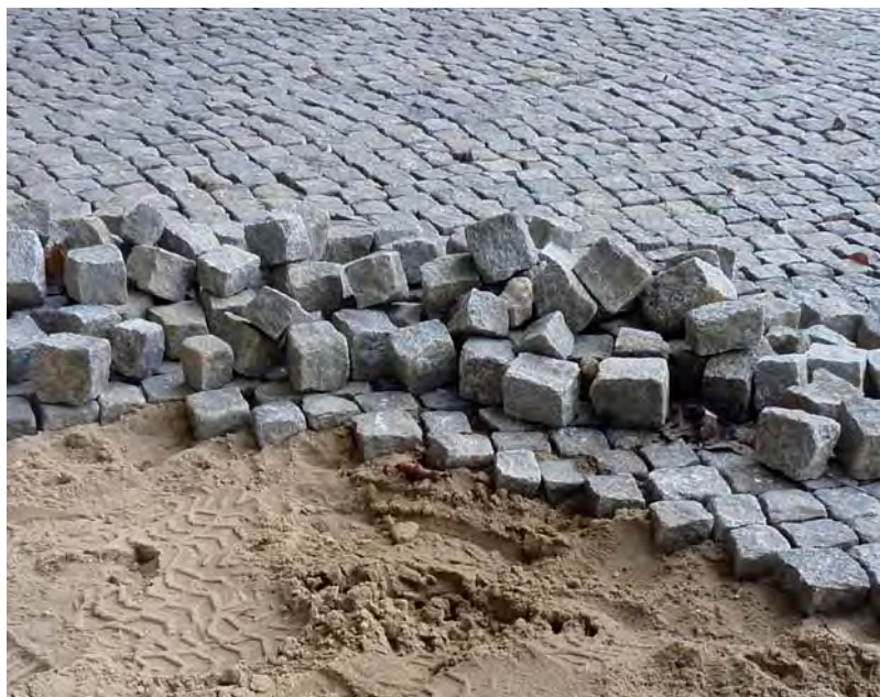
Abb. 45: Pflastersteine in ungebundener Bauweise lassen sich durch Ausbau und Einbau an anderer Stelle direkt wieder verwenden. So werden Ressourcen geschont und Abfall reduziert.
