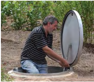
Abb. 44: Eine einfach durchzuführende Wartung vereinfacht Arbeitsgänge und spart Kosten: Begehbarer Schacht mit leichtgängiger Abdeckung.
