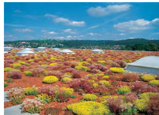
Abb. 46: Bei dieser extensiven Dachbegrünung wurden als mineralische Komponente des Pflanzsubstrates recycelte Ziegel verwendet.
