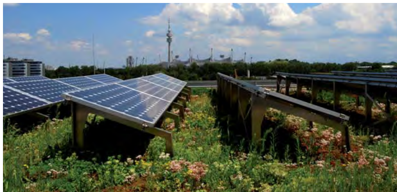
Abb. 29: Photovoltaikanlage auf einem Gründach
