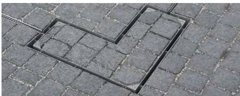
Abb. 40: Anpassung des Oberflächenbelags durch Auspflastern eines Revisionsschachts
