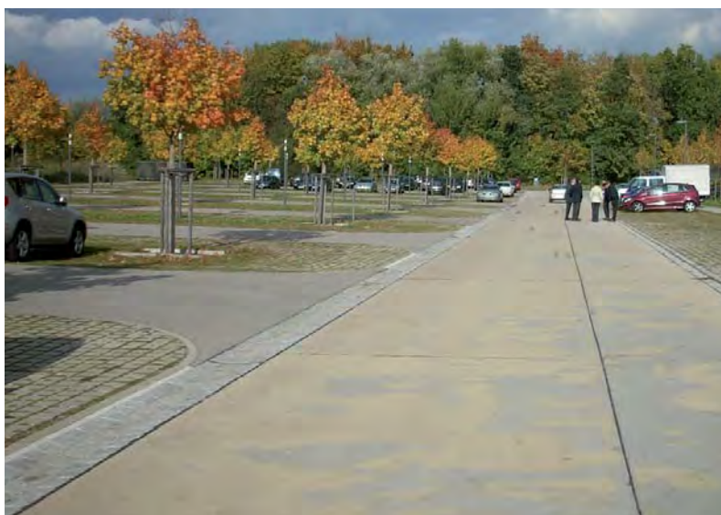
Abb. 16: Im Rahmen der Neuordnung des Bundeswehrstandorts konnten die Betonwegeflächen in die Neuplanung der Pinonierschule Ingolstadt integriert werden. Unter Verwendung des vorhandenen Belags im Bereich der Fahrbahnen bzw. des vorhandenen Schotter-Unterbaus im Bereich der Stellplatzflächen wurde dieser zu großen Teilen weitergenutzt.
