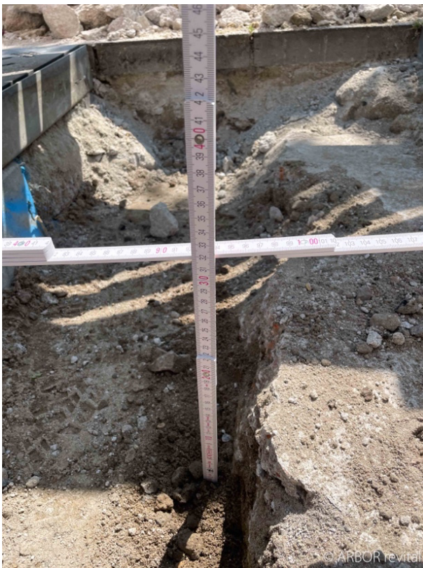
Abb. 26: Seitliche Darstellung der ca. 20 cm starken Betonschicht, als Unterbau des Pflasters. Aufnahme: 05.06.2023
