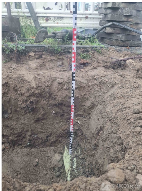
Abb. 34: Starkstromkabel in ca. 50 cm Tiefe, Aufnahme: 08.11.2023
