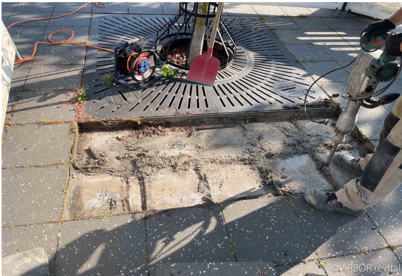
Abb. 18: Betondecke unter dem Pflaster an den Grabungsstellen der Kastanien FN01 und FN02, ca. 20 cm stark. Aufnahme: 06.06.2023
