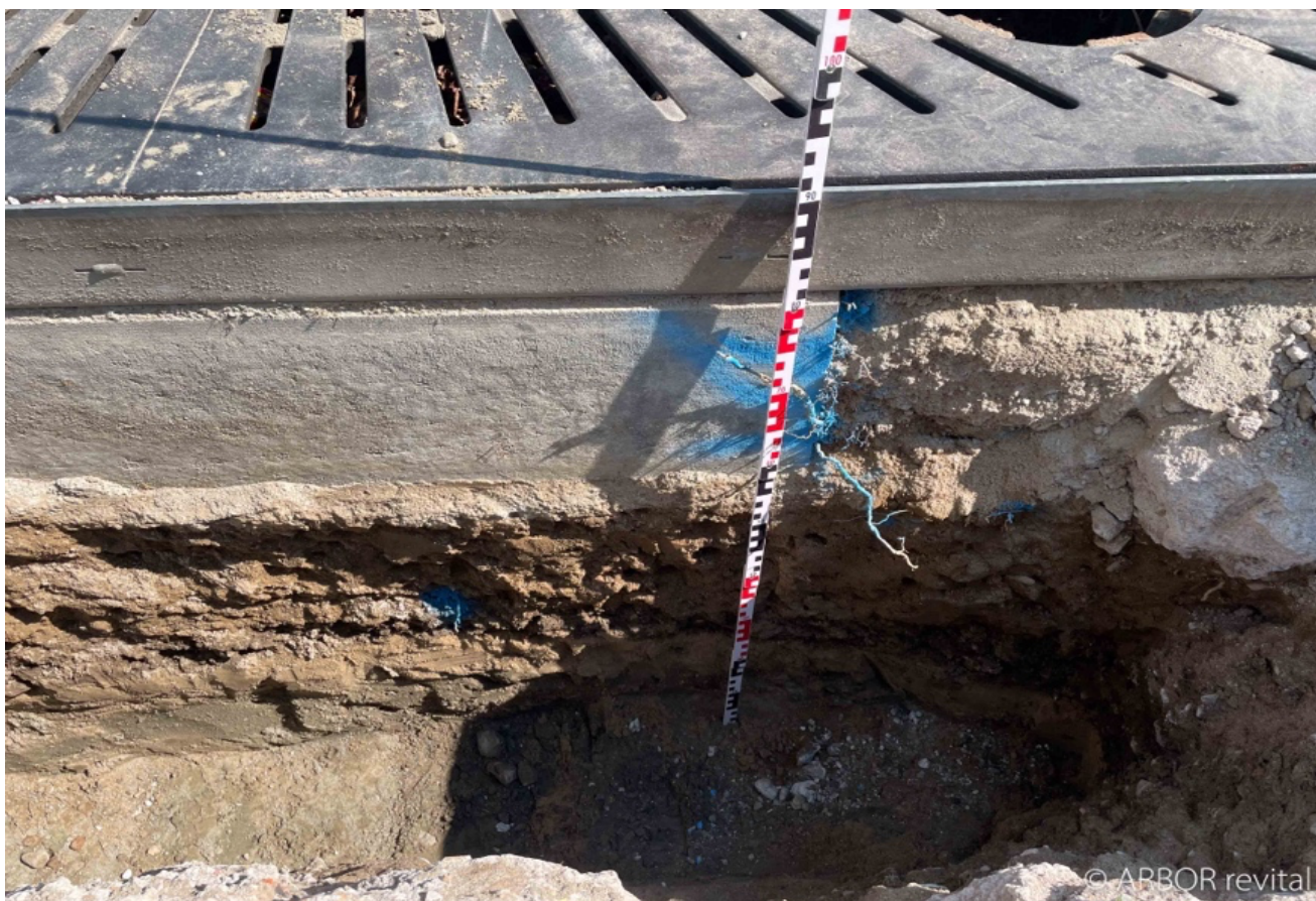
Abb. 29: Betonplatte verhindert eine gute Auswurzelung. Aufnahme: 05.06.2023
