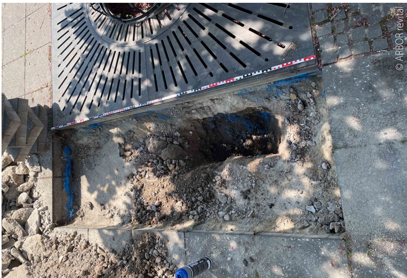
Abb. 19: Freilegung der Kastanie FN01, deutliche erkennbar die kaum vorhandene Auswurzelung unterhalb der Betondecke. Aufnahme: 05.06.2023.
