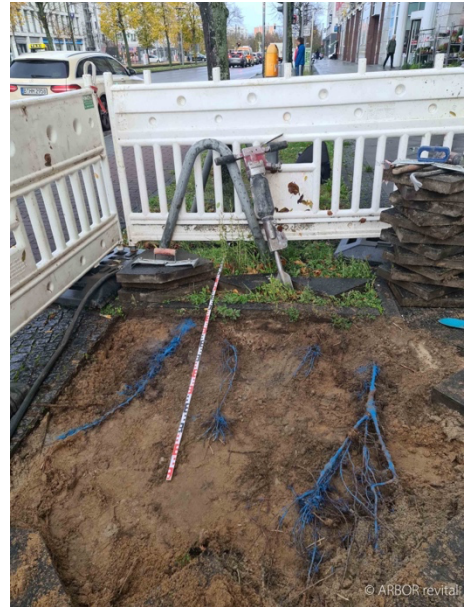
Abb. 33: Auswurzelung bis ca. 120 cm in das Pflasterbett, Aufnahme: 08.11.2023
