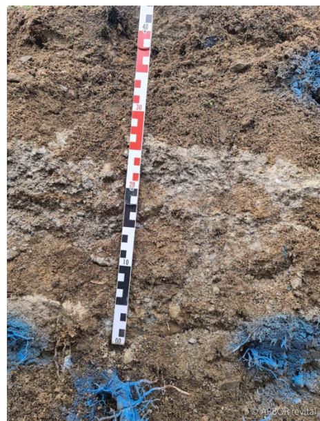
Abb. 42: Betonrückenstütze ca. 30 cm mächtig ab ca. 20 cm Tiefe, Aufnahme: 08.11.2022
