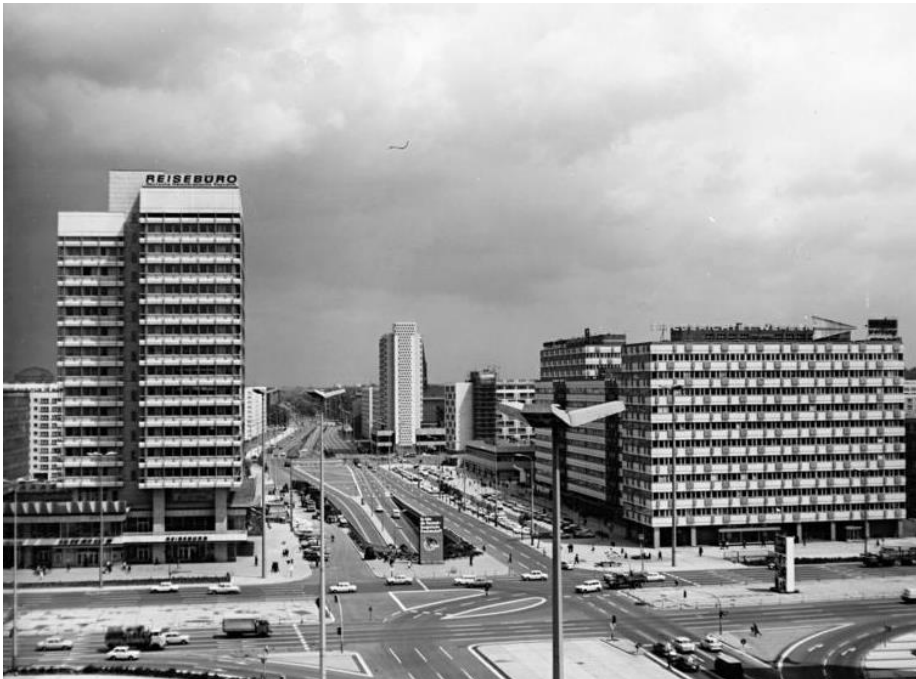
Abbildung 9 Haus des Reisens (links) und Haus der Statistik (rechts) | Quelle: Bundesarchiv, Bild 183-L0824-0308, Foto Peter Liebers
