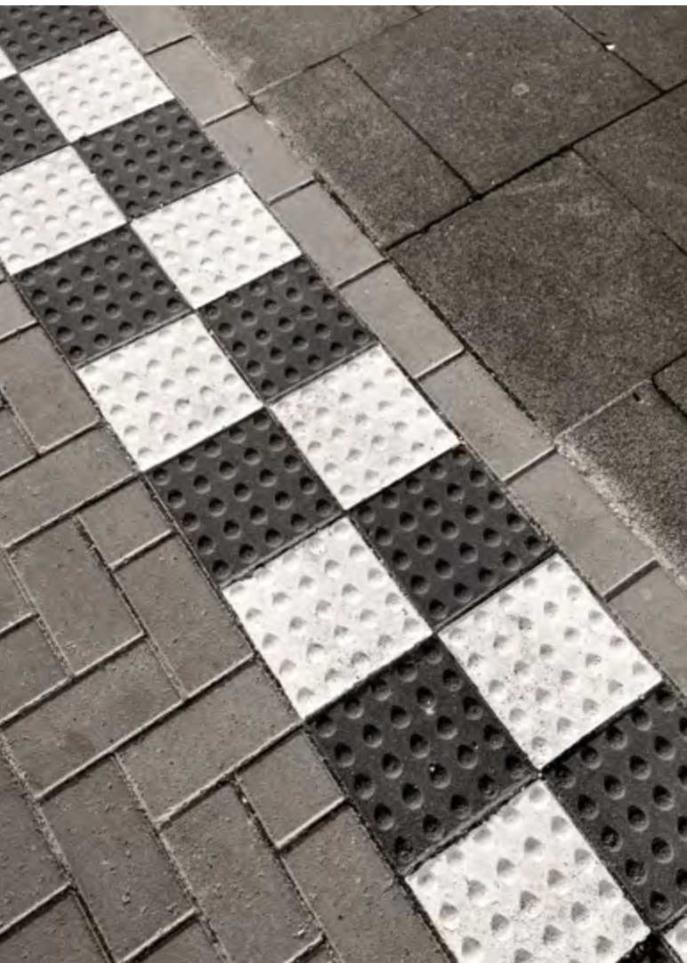
Taktil und visuell kontrastreiche Bodenstruktur als Wegeführung für sehbehinderte Menschen.
