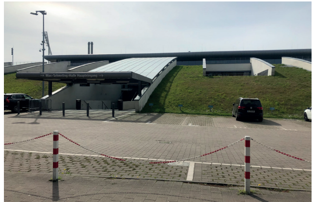
46) Blick von Osten auf die Max-Schmeling-Halle
