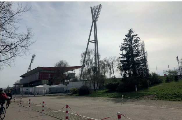
45) Blick von Nordosten auf das Tribünengebäude
