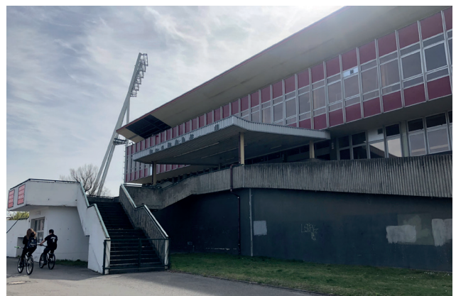
04) Blick von Nordosten auf das Tribünengebäude
