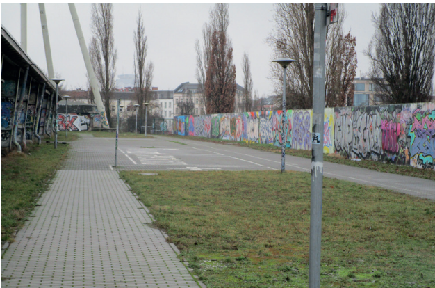
43) Blick von Norden zwischen Stadionrückwand und Hinterlandmauer
