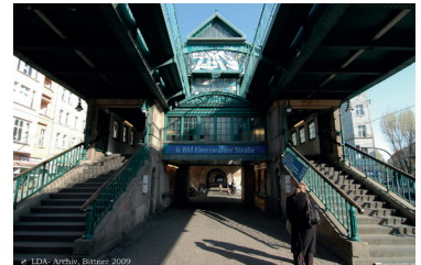
Abb. 26: (3) Hochbahnanlage, Quelle: LDA
