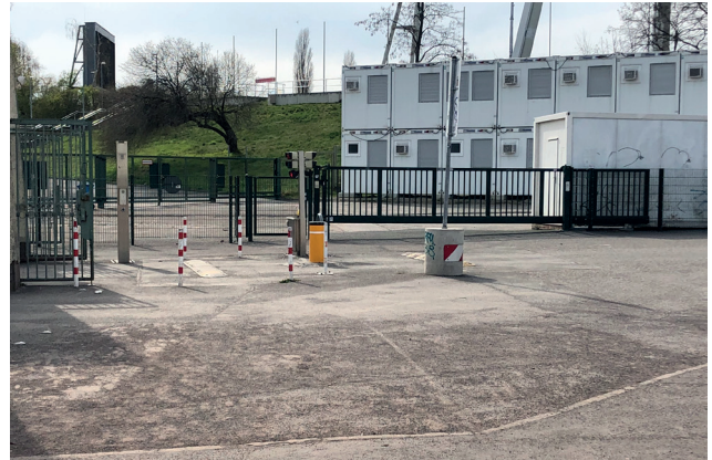
30) Blick von Südosten auf den Haupteingang
