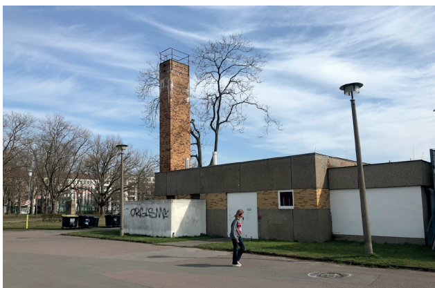
15) Blick von Nordwesten auf das Heizhaus
