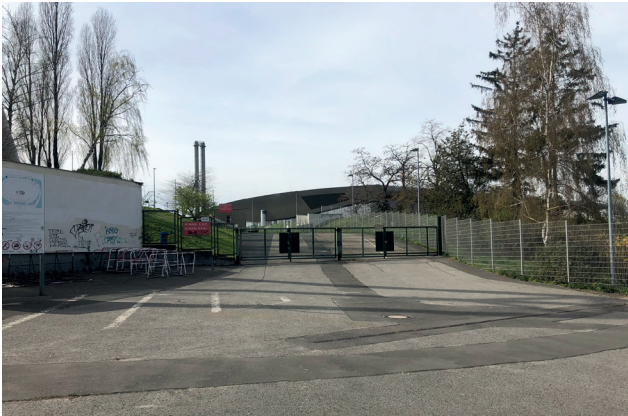
05) Blick von Osten auf die Feuerwehrzufahrt des Stadions
