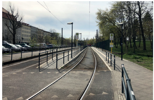
34) Blick von Osten über die Straßenbahnsteige
